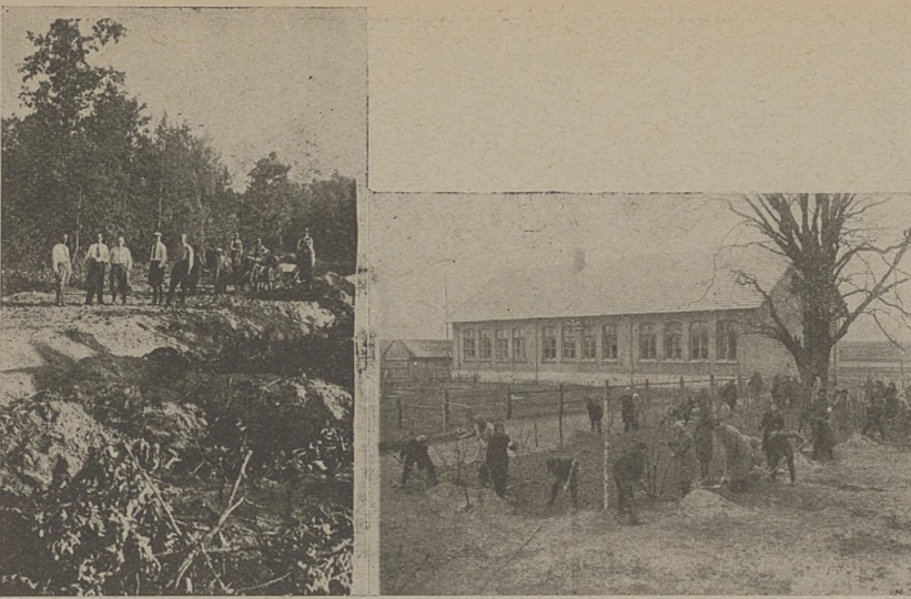
Na lewo: Fragment budowy drogi; Na prawo: Sadzenie drzewek przed 4-o kl. szkołą powsz. odbudowaną przez gm. Kisielin w r. 1924.
