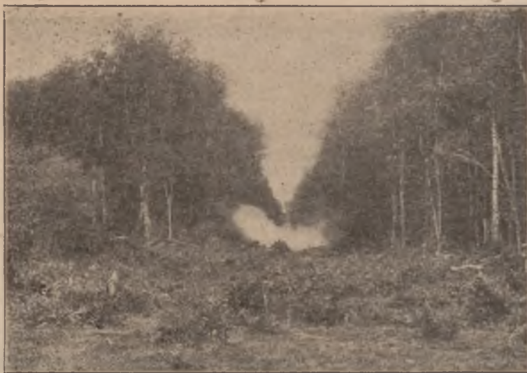
Karczowanie pni drzewnych materiałem wybuchowym na trasie kanału.
