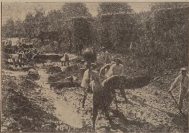
Podczas pracy na kanale gen. Żylińskiego.
