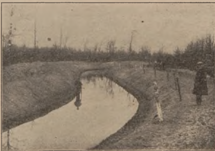
Fragment ukończonego kanału.
