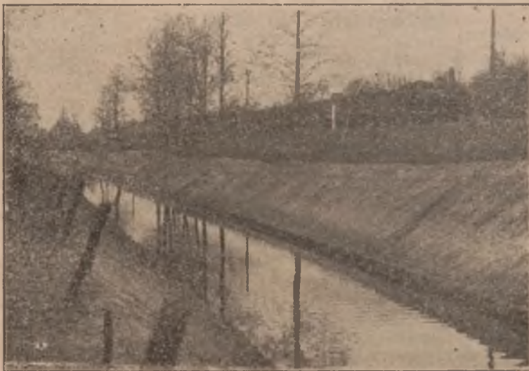
Widok kanału po ukończeniu robót
