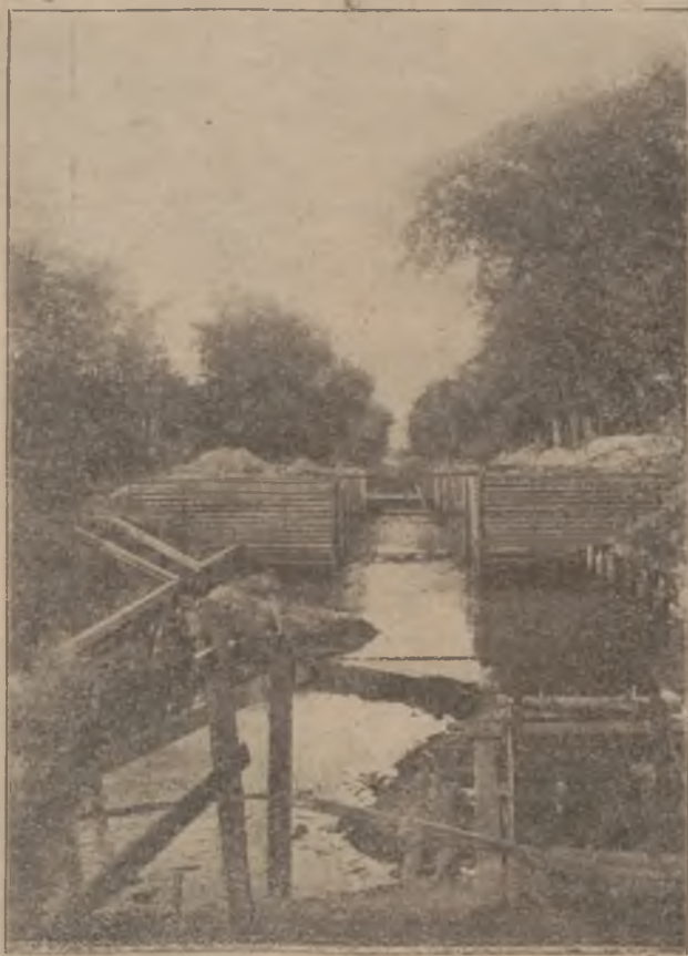
Budowa szluzu w Telechanach na kanale Ogińskiego.
