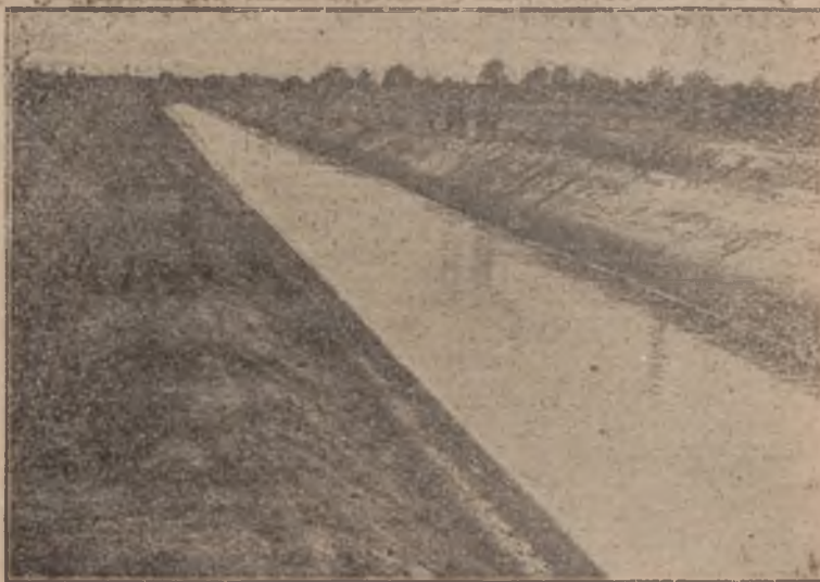
Kanał po ukończeniu robót.
