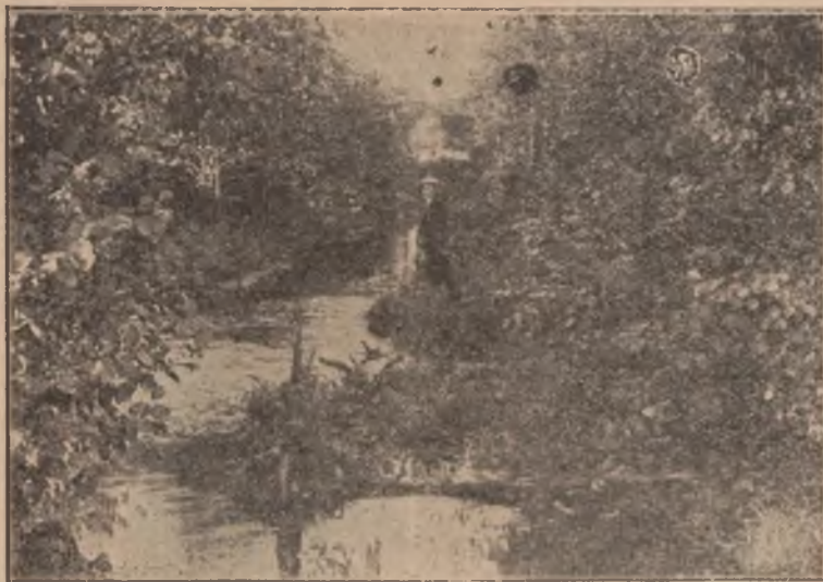
Kanal w obecnym stanie (przed odbudową).
