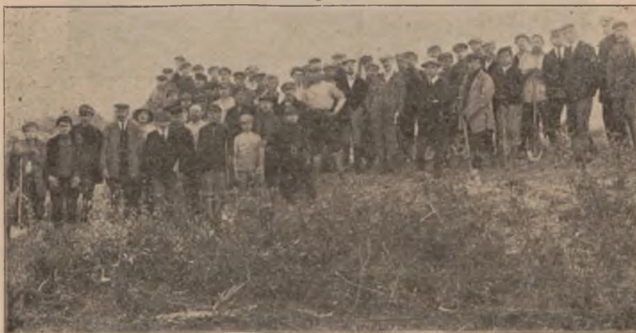
Stan jednego z odcinków kanału Żylińskiego przed rozpoczęciem robót.
