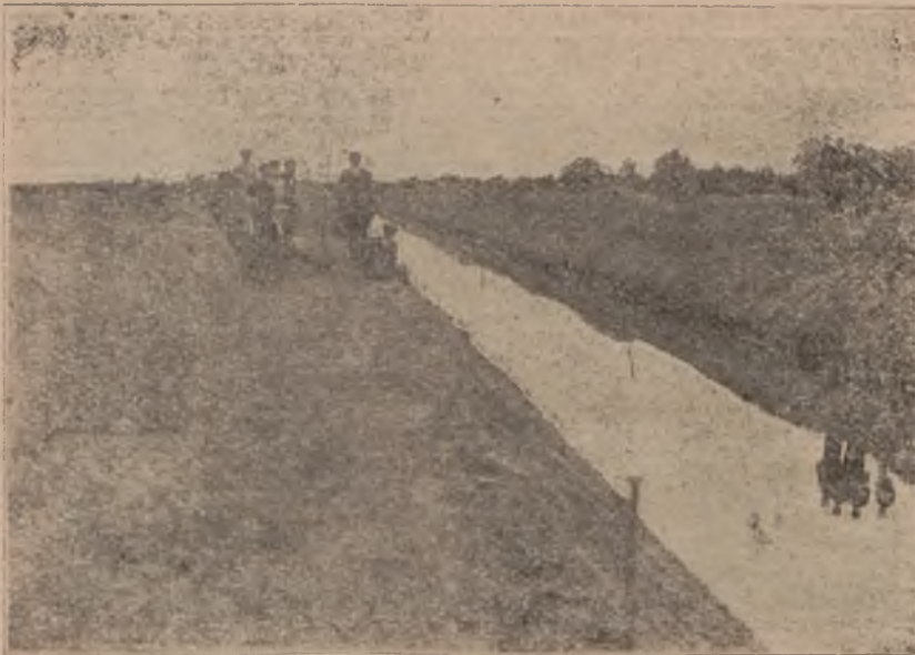
Odcinek kanału przed ukończeniem robót.
