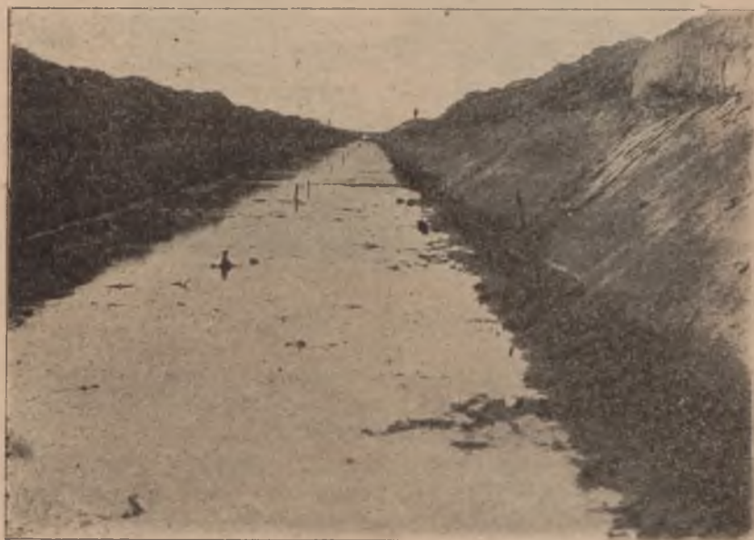
Odcinek kanału w trakcie roboty.
