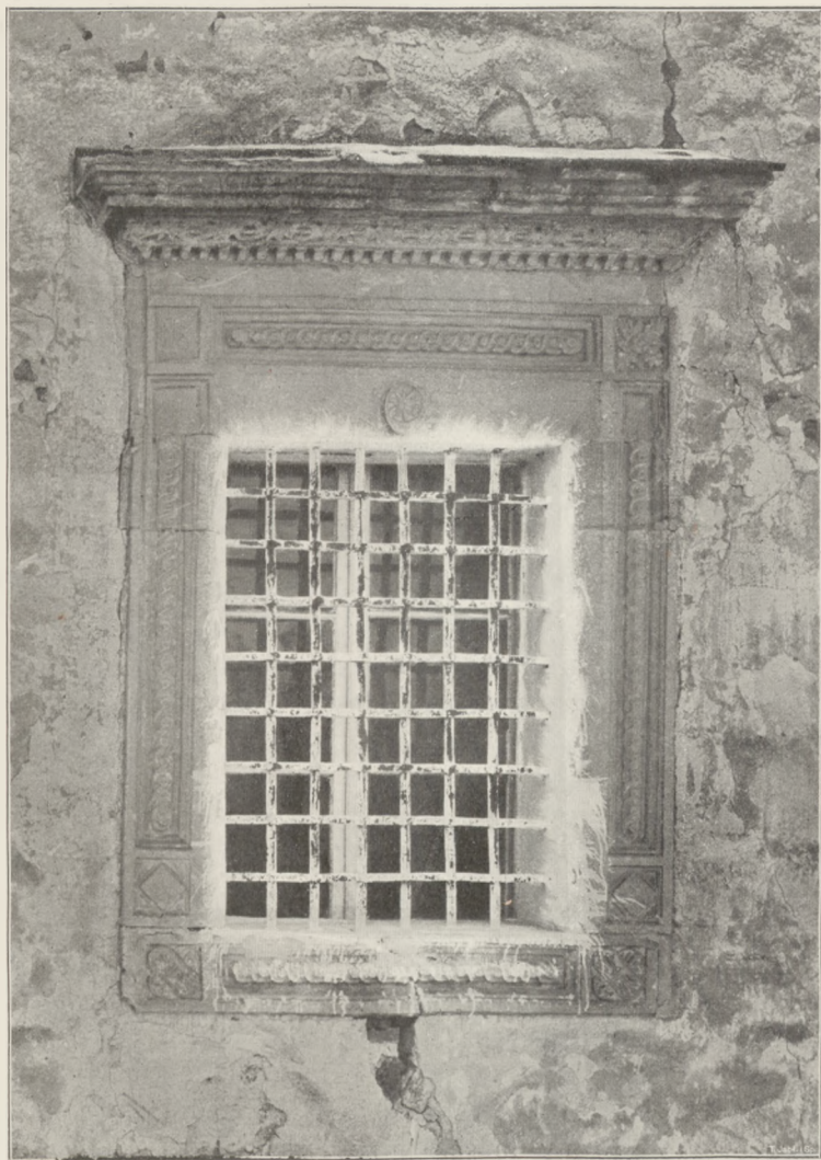
Fig. 3. Okno parterowe w fasadzie wschodniej.
