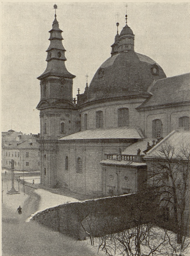
Fig. 8. Tarnopol, kościół OO. Dominikanów. Kopuła przed odrestaurowaniem.
