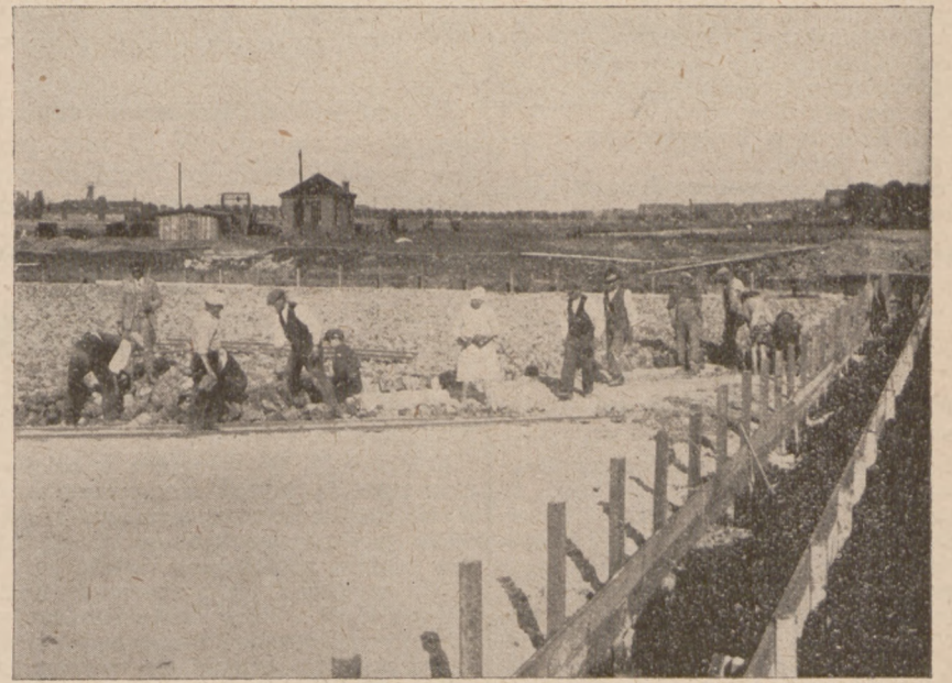
Z każdym dniem widać na torze po stępy. Robotnicy zakładają warstwę izolacyjną. Roboty wykonuje firma T. B. J.
