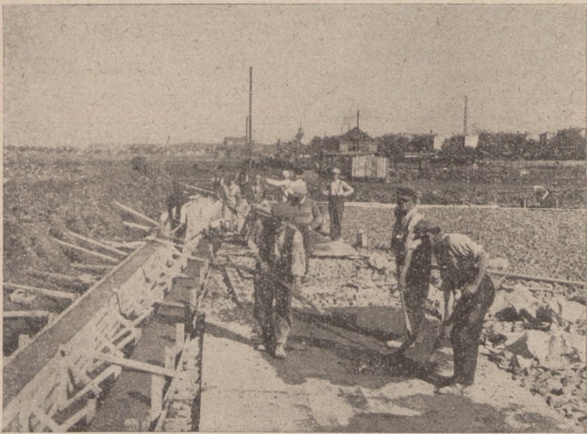
Jak widać praca wre i budowa postępuje szybko naprzód. Zakładanie żelbetonowych krawężników. Roboty wykonuje firma T. B. J.
