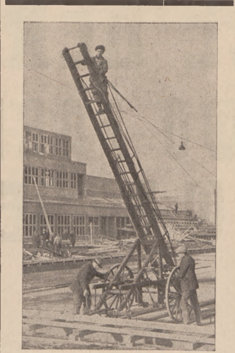
Zakładanie reflektorów oświetlających sztuczny tor łyżwiarski.
