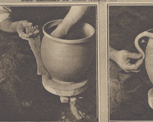
Przy pomocy „smalanych” i „konek” drewnianych obrabia garncarz swój przedmiot, przysiadając go obracać na kole, poruszonym nogą.
