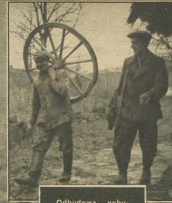
Odbudowa poburzonych domów to ciężka robota, ale to ręce przyswycapają się do pracy. Chała musi w każdym razie być tak daleko doprowadzona w budowie, by można w niej już przemieszwać.
