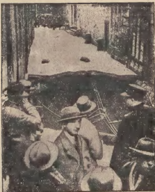
„Via Nuova“ na skutek podmycia bruku przez pęknięcie rury wodociągowej.
