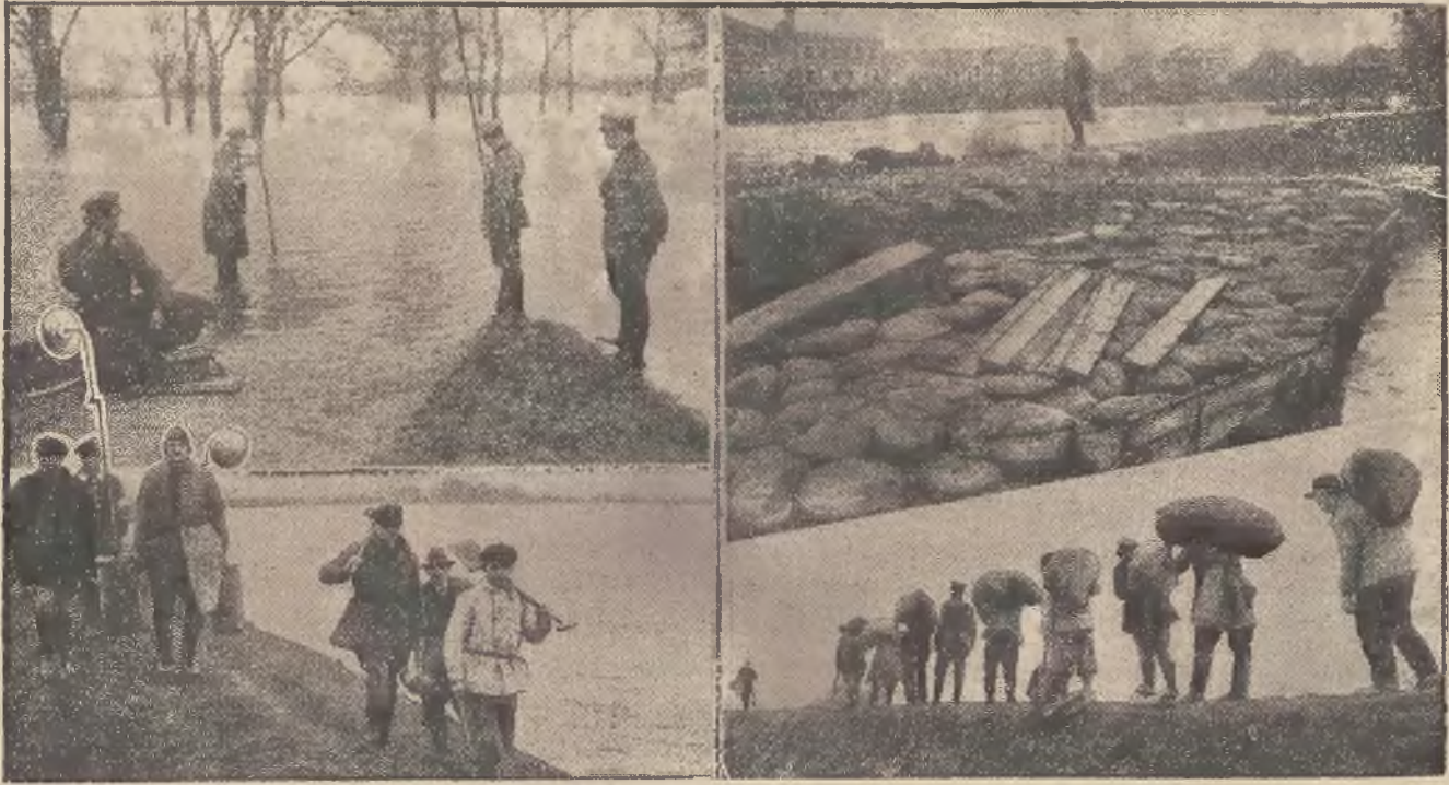
Na górze od lewej: Saperzy badają stan wody, obok sztuczna tama zbudowana z worków z piaskiem, na dole oddziały ratownicze podczas akcji.
