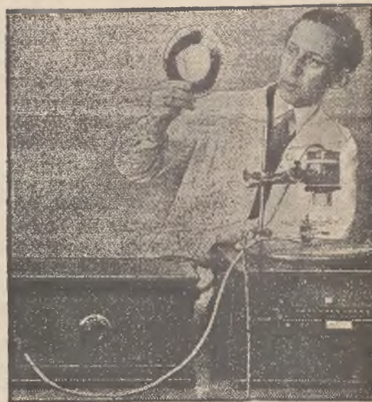
Lekarz berliński, dr. Leon Jakobsohn, skonstruował aparat, za pomocą którego można uchwycić na płytę bicie serca ludzkiego. Podstawą aparatu jest komórka światłoczuła. Wynalazek ten ma nadzwyczaj doniosłe znaczenie dla wiedzy lekarskiej, gdyż pozwoli ustalać z największą dokładnością wszelkie szmeru sercowe.
