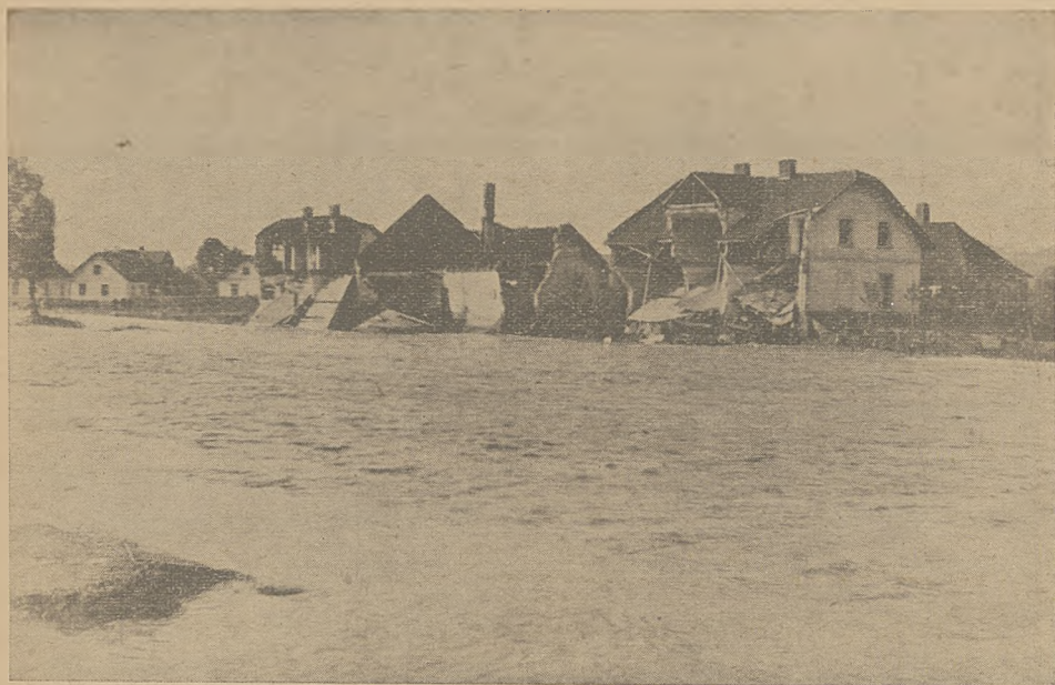
Gdy rzeka Kamienica ustąpiła: widok zwalonych przez rzekę Kamienicę domów przy ul. Kraszewskiego
