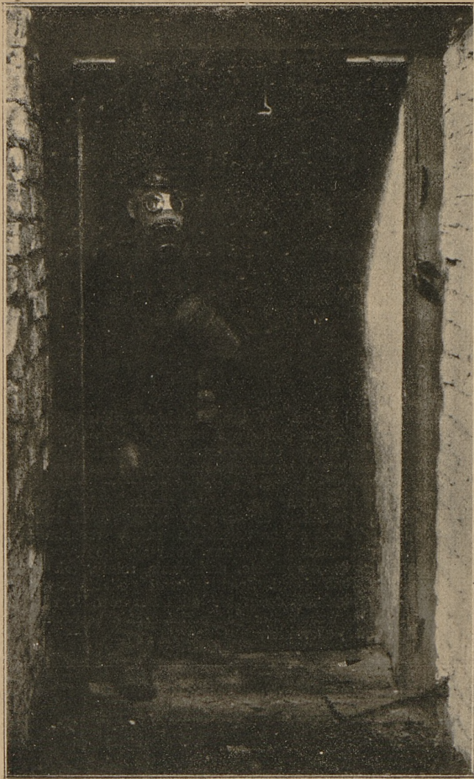
Rys. 2. Roleta opuszczona i uszczelniona po bokach listewkami. Poprzeczki, chroniące przed wklęsnięciem, widoczne. Obsługujący w masce przeciwgazowej.
