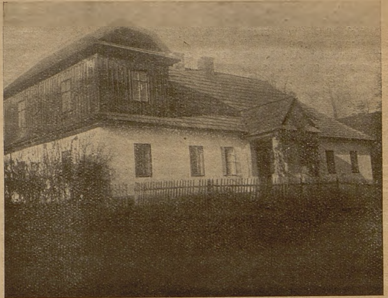
Plebanija w Tłuczani pochodzi z r. 1783 i jest zbudowana w stylu zaścianka kościuszkowskiego.
