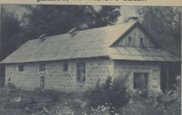
Przy odbudowie Piasecznej jednym z najpopularniejszych materiałów są bloki betonowe, t. zw. pułki
