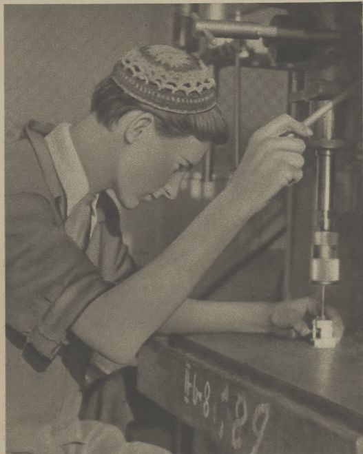
Wiercenie otworów (lampy dwuciecznej)
