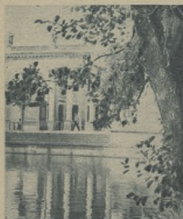
Remontowany pałac w Łazienkach.
