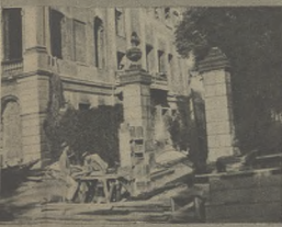
Odkryte smutaki Uniwersytetu Warszawskiego są zniszczone przez wojnę. Teraz dopiero przystępują do odbudowy i remontu.
