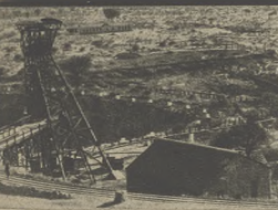
Kopalnia wanału pod Grootfontein w Rodezji.
