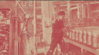
MŁODY FREZER BŁASZCZAK TADEUSZ PRZY WYKONYWANIU KWADRATÓW SŁUŻĄCYCH DO UCHWYCENIA KLUCZY
