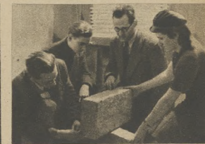
Grupa studentów przy badaniu betonitu. Jest to cegła wyrobiona z gruzu rzeźnane, piasku i cementu — według pomysłu prof. Zalewskiego. Znalazcie ona szerokie zastosowanie przy odbudowie Warszawy.
