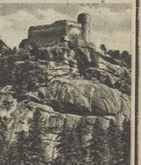
Zamek Chojnasty — wyrasta nagle przed nami kopuła góra z ruinami zamku, otmurawiona rękami przyrodo ze wszystkich stron ciekawymi blokami skalnymi.
