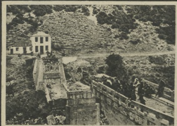
Most został zburzony podczas odwrotu przez wojska faszystowskie. Nie powstrzymuje to jednak pochodu demokratycznej armii ludowej. Saperzy na niezburzonych przesłach przerzucili już most tymczasowy.
