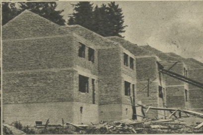
W czasie wojny Litwinowo zostało dotkliwie zniszczone. Wiele robotników nie miało gdzie mieszkać. Naturalnie, że ucierpiał na tym przemysł miejscowy. Dzisiaj brigady młodzieżowe mieszczą w drewnianych barakach i budują murowane domy, dla robotników miejscowego przemysłu. Ale młodzież nie tylko pracuje: uczy się i uczy innych. Organizuje kursy dla robotników, odczyty i pogadanki. W ten sposób odbudowuje swój kraj materialnie i kulturalnie
