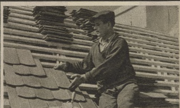
Sezon budowlany już się rozpoczyna. Musimy w tym roku budować dużo i szybko. Robotnicy kryją dachówką jeden z domów przy ul. Nowy Świat w Warszawie. Wszystkie domy przy tej ulicy, dla zachowania jej dawnego charakteru, mają być pokryte dachówką. Młodzi pracownicy budowlani przywracają Warszawie jej dawny, piękny wygląd.
