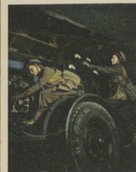
Obsługa motoru wytwarzającego prąd dla stacji podsłucha radiowego.
