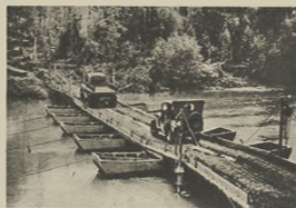
Szybko zbudowane mosty pontonowe.
