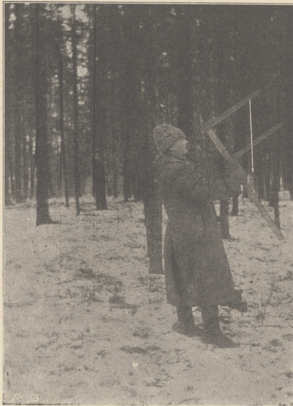
Fig. 1. Tastr-wysokomierz Zwolanowskiego przy użyciu do mierzenia wysokości drzewa.
