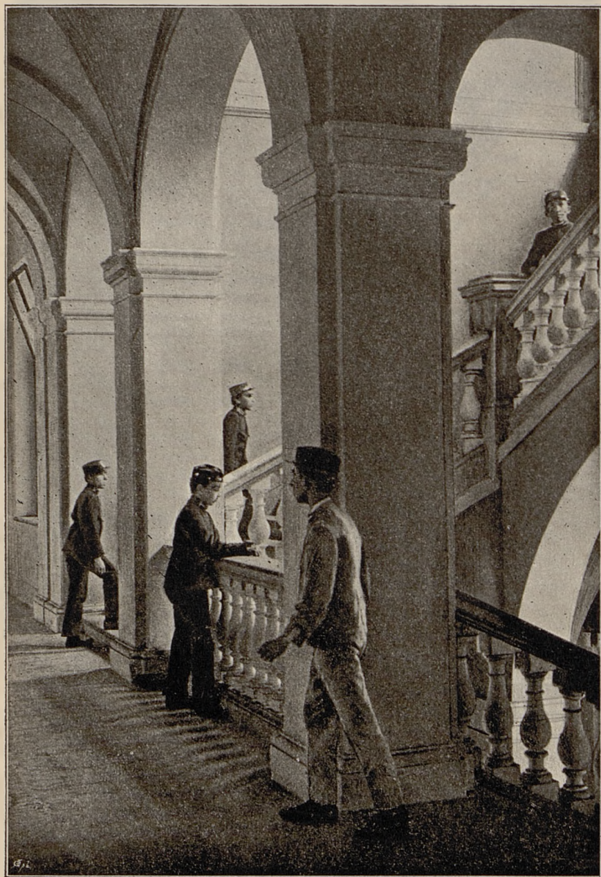
Fig. 4 Klatka schodowa na I. piętrze.
