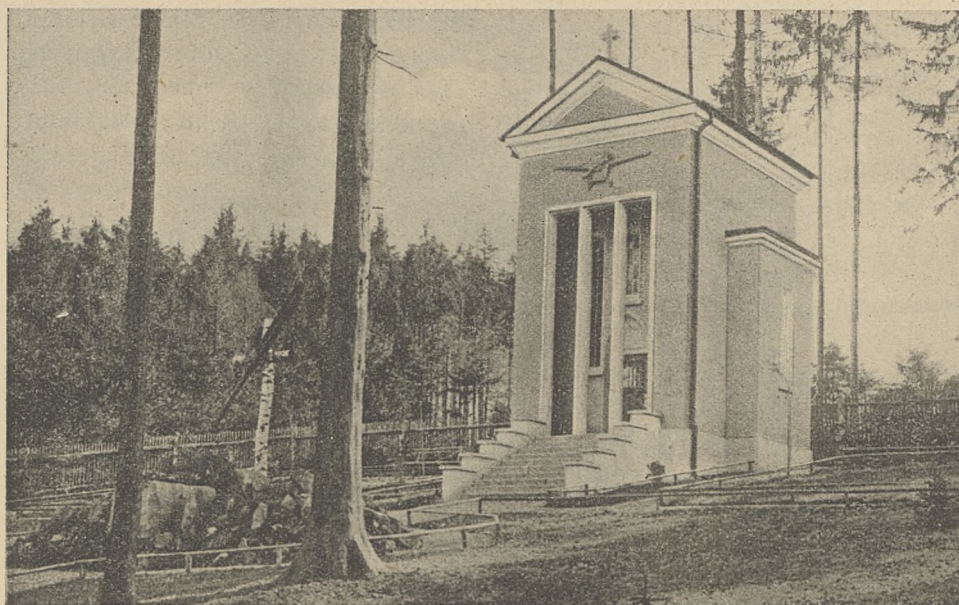
Kaplica „Żwirki i Wigury“ w Cierlicku Górnym.
