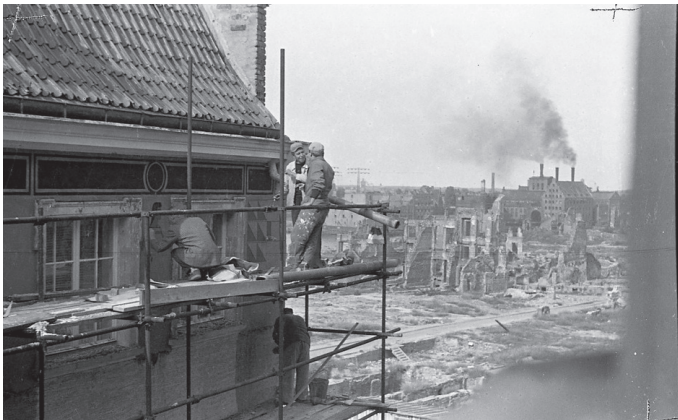
Fot. 8. Widok z rusztowania na zniszczony Gdańsk (lata pięćdziesiąte XX w.) Źródło: Fot. Zygmunta Szymoniaka, sygn. X/46/358.
