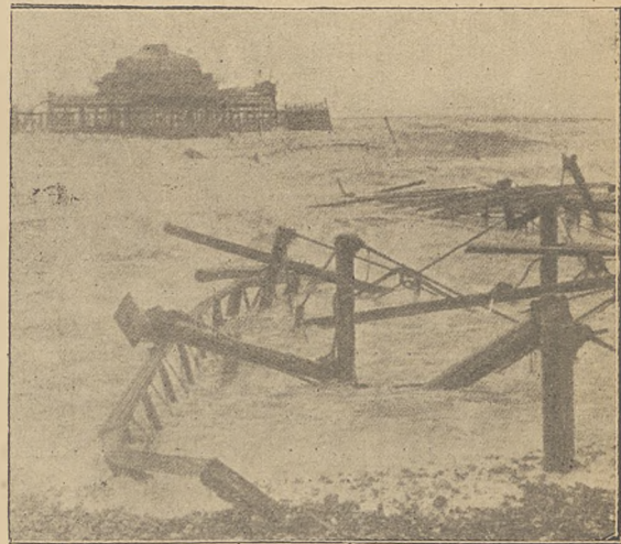
Most zerwany przez powódź.
