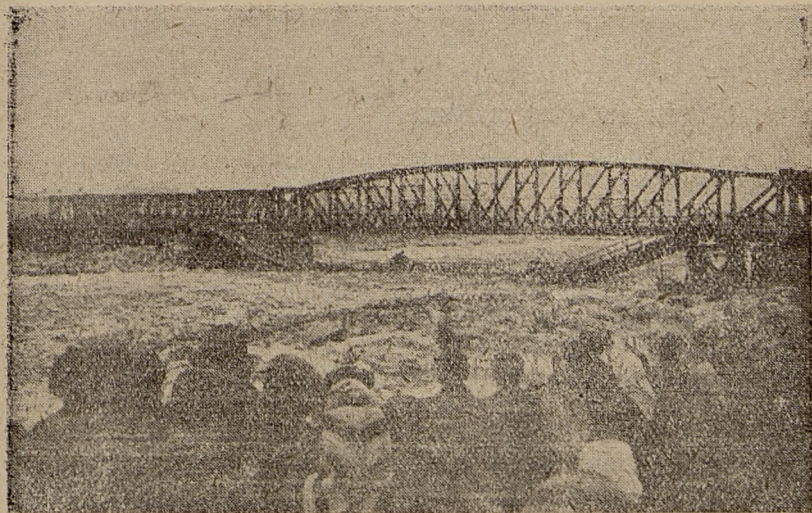
Rys. 5. Kolejowy most objazdowy zniszczony przez zator lodowy
