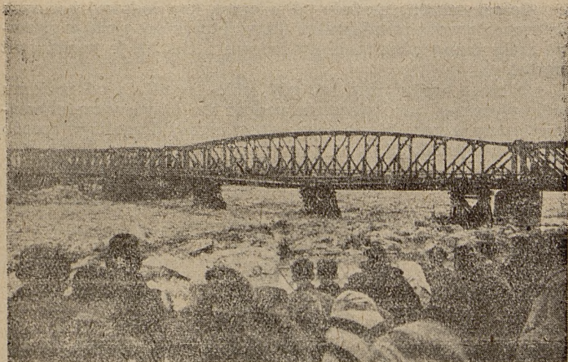
Rys. 4. Wiosenny pochód lodów. Kra lodowa zwycięsko atakuje podpory kolejowego mostu objazdowego
