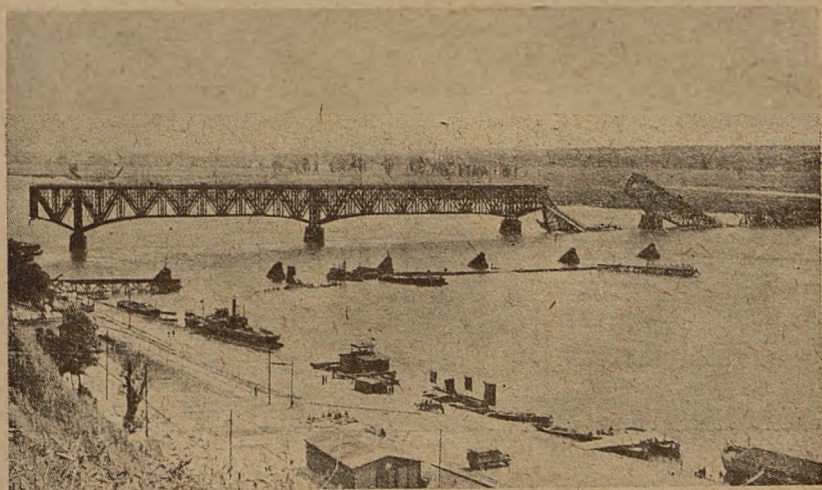
Rys. 2. Częściowe zniszczenie mostu stalowego
