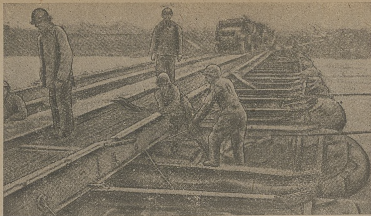
Rys. 4. Most kolejowy ze sprzętu amerykańskiego parku M-I, wybudowany na 12-tonowych łodziach gumowych.
