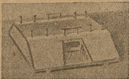
Rys. 2. Rozkładany model drewnianego przepustu w nasypie drogi
