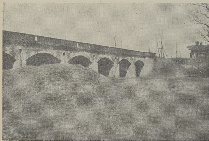
Zdjęcie 11. Przęsła i filary z kamienia i cegły
