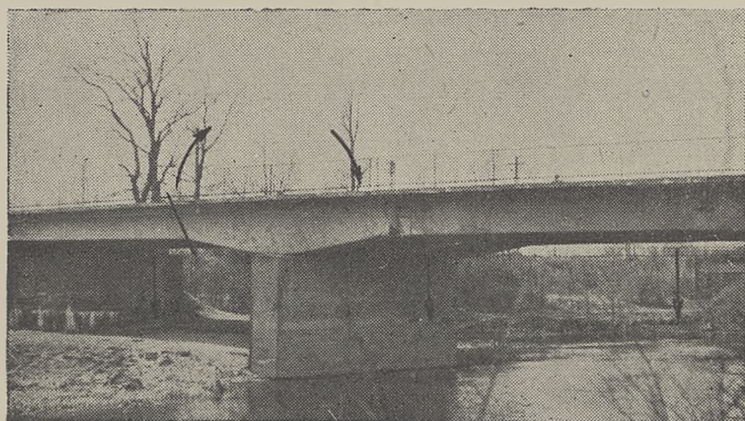
Zdjęcie 18. Zamiar niszczenia przęsła
