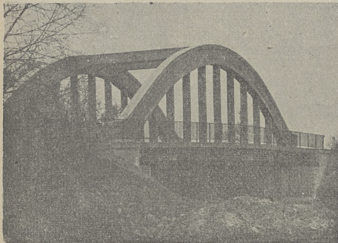
Zdjęcie 1. Obiekt nr 2F — most dro- gowy na rzece Cicha w rejonie 0,5 km pld m. Zielno (widok ogólny)
