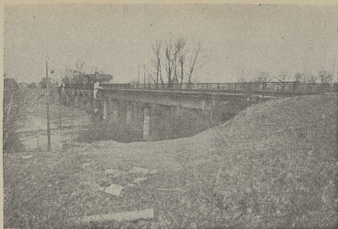
Zdjęcie 9. Obiekt nr 7F — most kolejowy na rzece Cicha w rejonie 8,4 km wsch. od mostu drogowego — obiekt nr 2F (widok ogólny)
