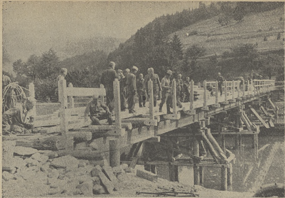
Rys. 6. Fragment budowy mostu jednokierunkowego
