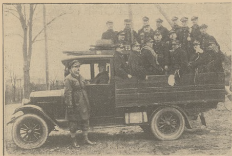
Oddział P. P. W. Bydgoszcz I. Grupa budowlana Wyjazd na ćwiczenia pierwszego półplutonu.
