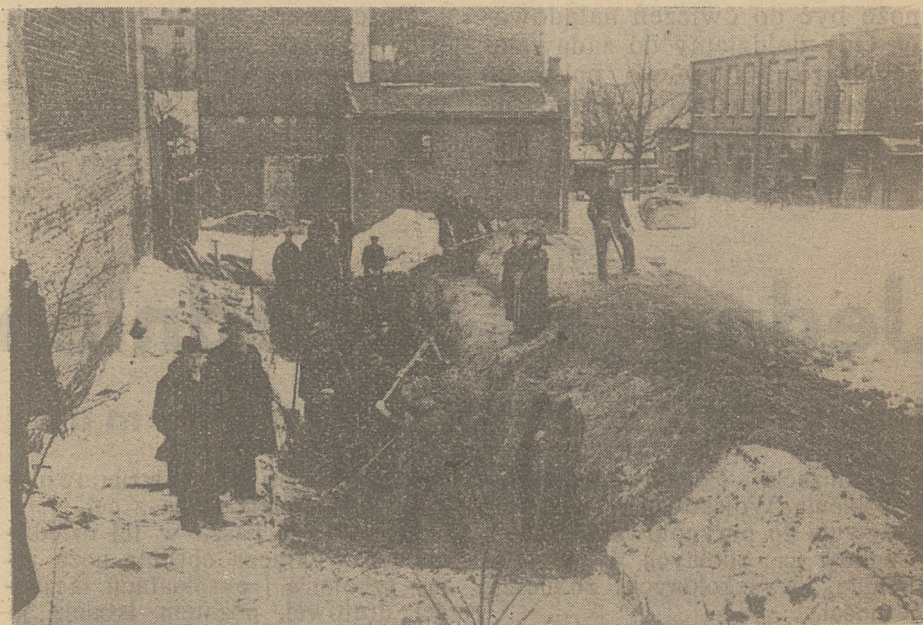
Członkowie oddziału PPW Łódź przy budowie własnej strzelnicy.
