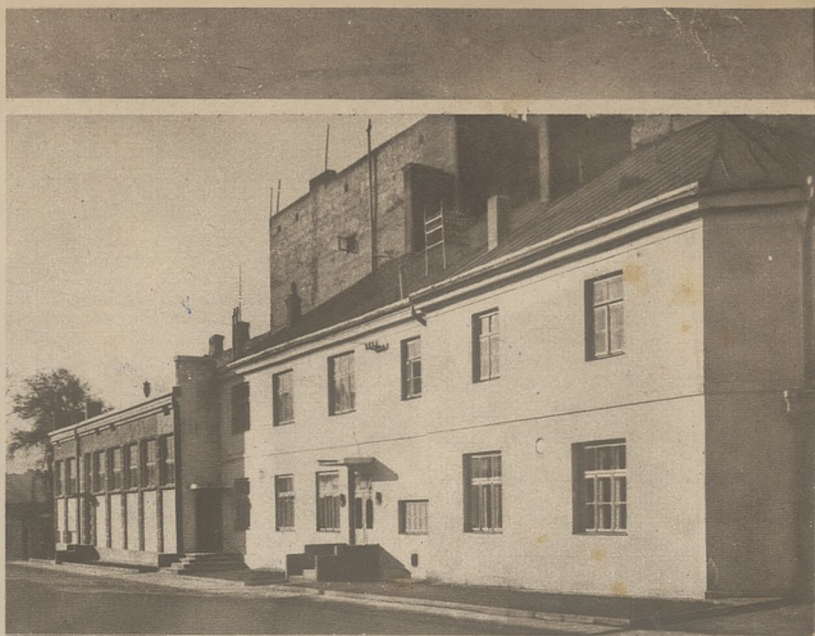
Budynek świetlicy PPW w Lublinie.
