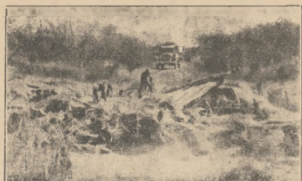
Na równinie Bahora. Naprawa zniszczonego przez powódź mostu
