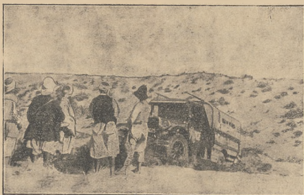
Budowane przy pomocy tyłuśców „jezdnie”, wykładane chrustem pustynnych krzewów afrykańskich.
