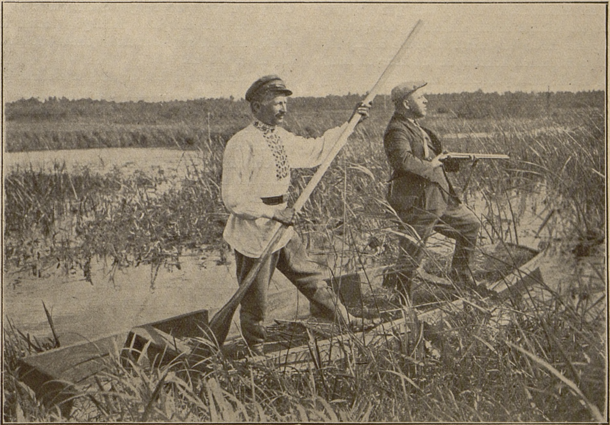
Na rozlewiskach Polesia.
