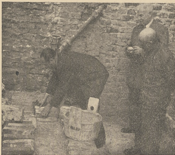
Zakładanie fundamentów pod siedzibę PZŁ.
