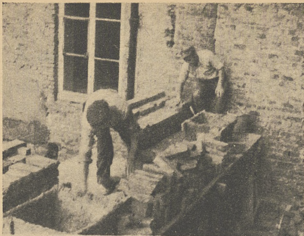
Migawki z budowy
