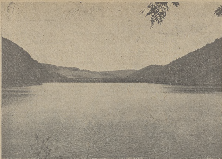
Widok na jezioro Chojna. W głębi zapora piętrząca.
