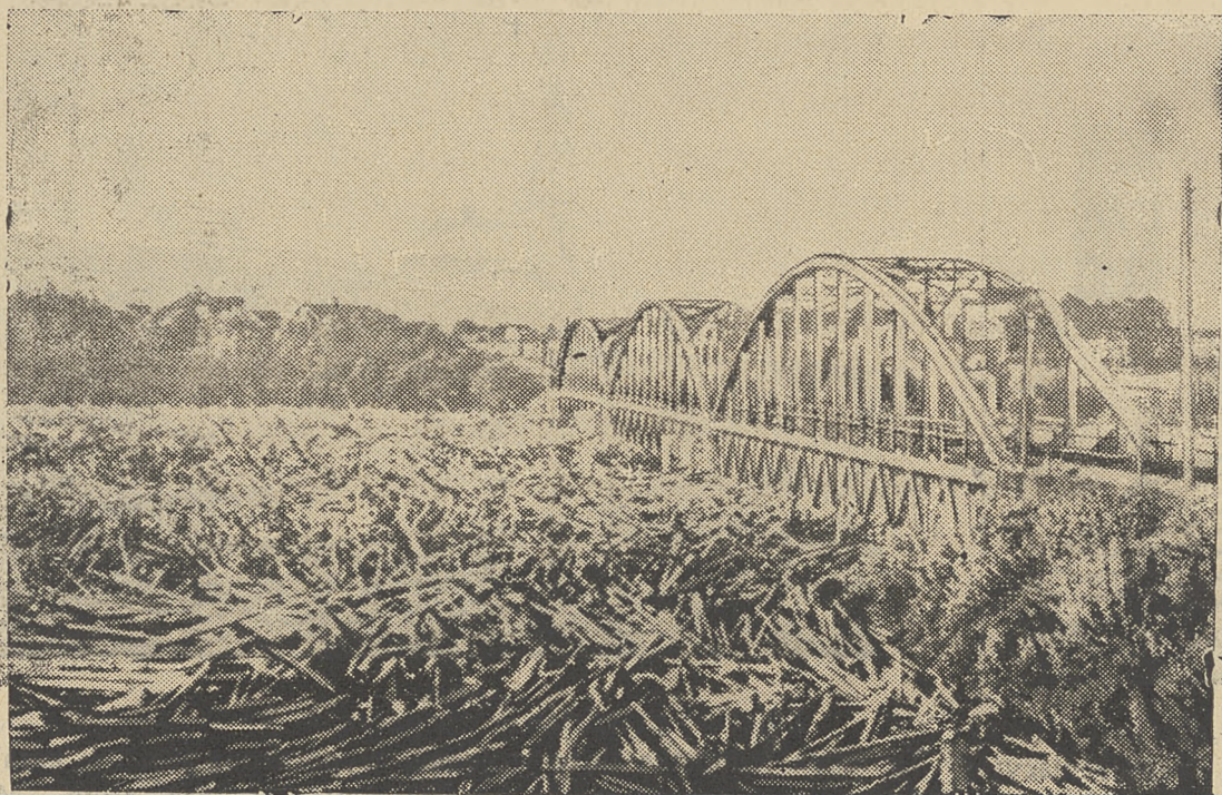
Miasteczko Vaennaes Móśc kolejowy pod Vaennaes prowadzący do Laplandji, został zaatakowany przez 8 milionów pni drzewnych i grozi lada chwilą zawaleniem się.
