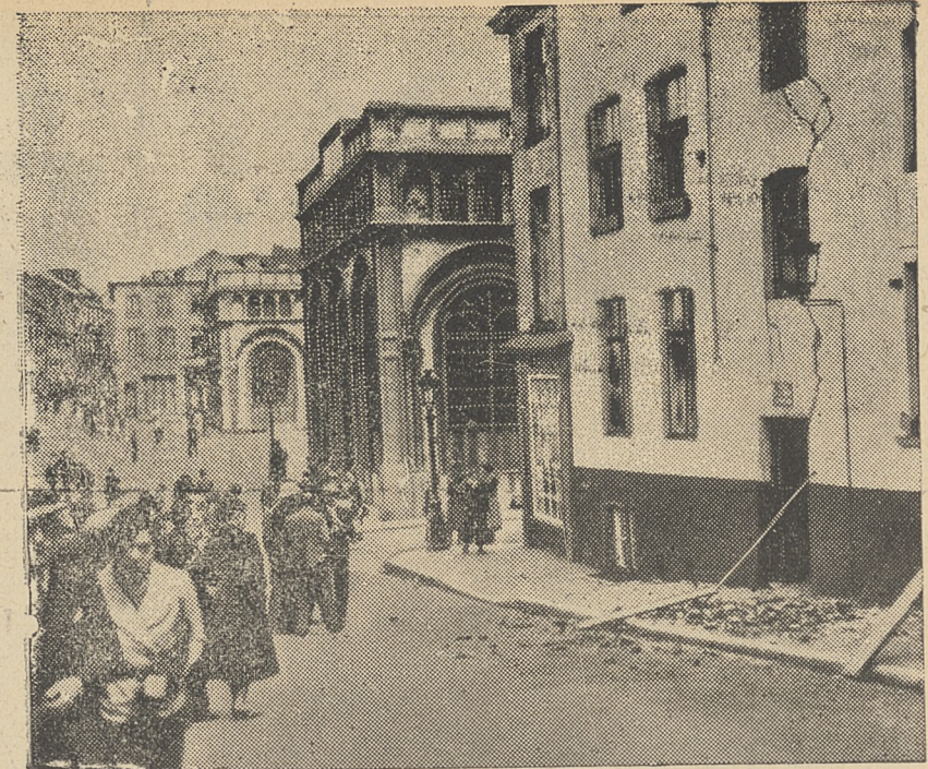
Jeden z domów w Brukseli, które zarysowały się podczas ostatniego trzęsienia ziemi.
