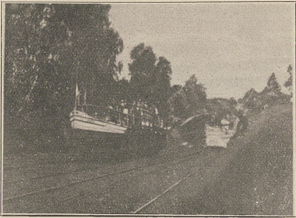
Parowce zostają przetransportowane z jeziora Drunzy do kanału Oberlandzkiego o 100 metrów wyżej położonego.
