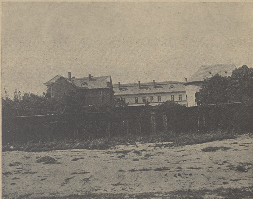
Widok budującego się nowego klasztoru i kościoła SS. Karmelitanek Bosych w Poznaniu.
