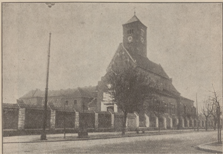
Widok naszego kościoła w Krakowie z wykończoną fasadą i murem od ul. Rakowickiej.
