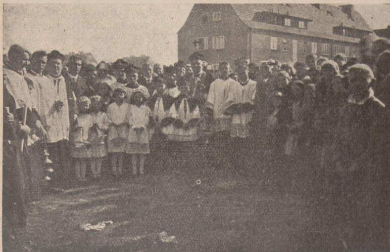
Na poświęconym placu budowy nowego kościoła „malej św. Teresy“ w Mikulczycach.
