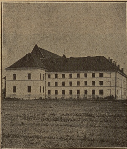
Nowowynbudowany, nie wykończony jeszcze klasztor OO. Karmelitów bosych na Persenkówce we Lwowie.
